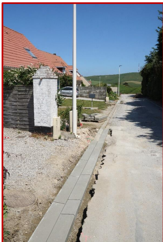
Nouvelles bordurations et réfection de la chaussée et des trottoirs
