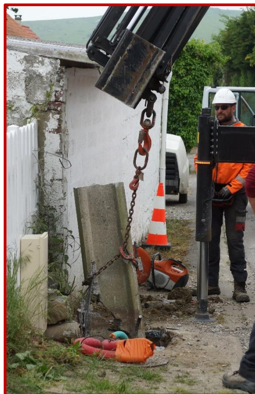
Dépose des anciens candélabres
