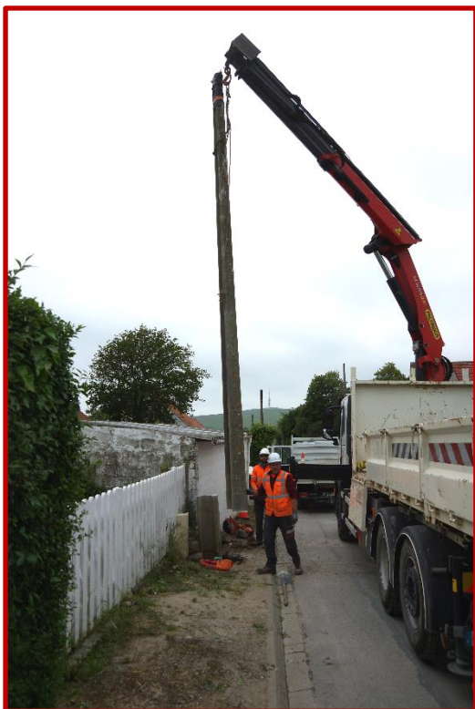
Dépose des anciens candélabres
